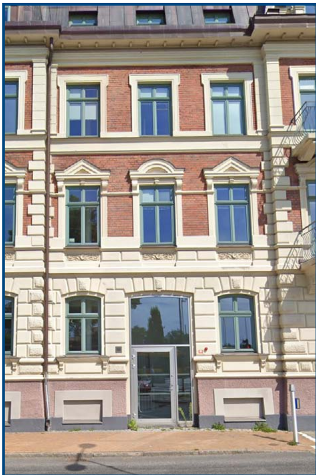
Ingången Västra Boulevarden 13.
